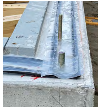
「天端リスト 100」施工例*
