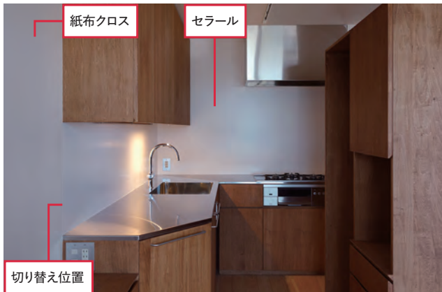
キッチンの壁面にセラールを用いた例（鳥が丘のヒノキハウス）。手前側の壁には紙布クロスを採用
