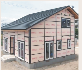
耐久性も考えた丁寧な気密施工
