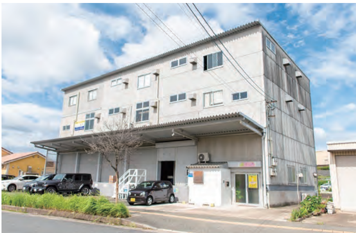
同社の事務所兼工場の外観。鉄骨造3階建てで1・3階が作業場、2階が資材置き場。使用している面積は1・3階が各350㎡程度、2階は175㎡程度
