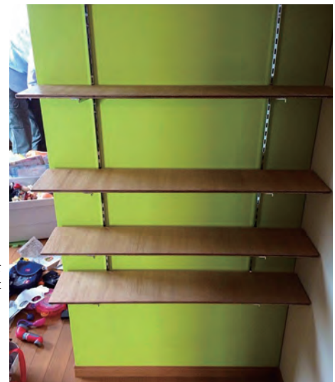
壁の一部にガチャ柱を埋め込み開放棚を設けた
