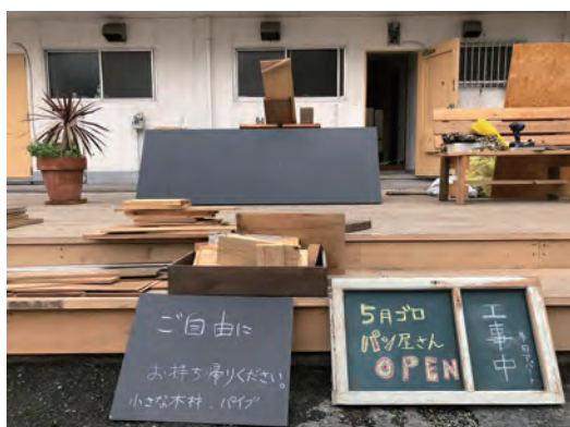
パン屋の施工中の様子。開店の告知を兼ねてDIYに使えるような廃材を提供
