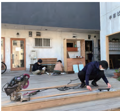
ウッドデッキがあるとDIYの作業場にもなる
